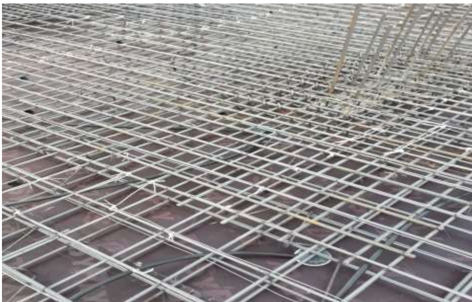
8-сурет-Монолитті аражабындағы сымдардың құрылғысы
